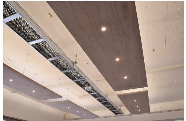
吊り天井を外して間接照明を直付け
